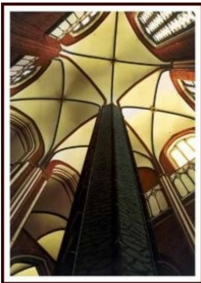
Abb. 2b Kreuzrippengewölbe mit Schlußsteinen und Säulen
